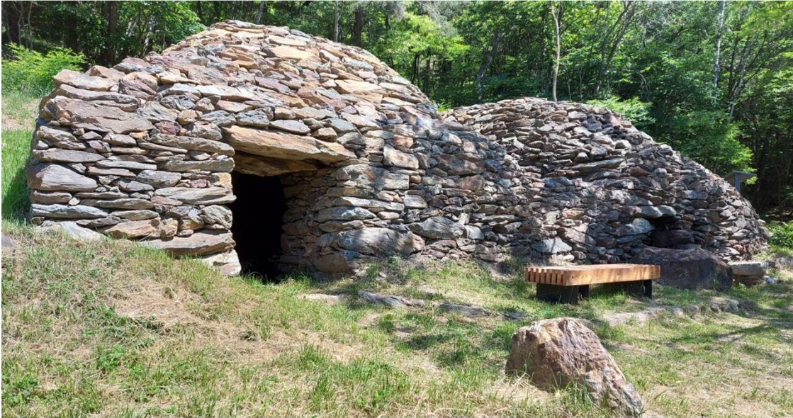
Foto 1: Baitèi restaurati a Sernio (foto di Severino Bongiolatti)
