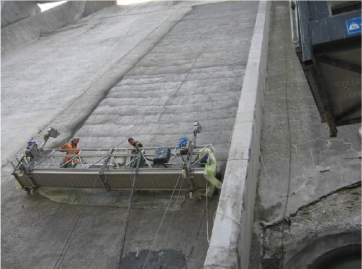
*Figura 11 – Lavori 2<sup>a</sup> lotto, stesa di intonaco sul paramento di valle della diga – soglie 7 e 8, 2010*
