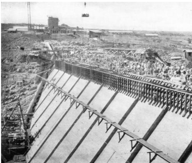
Figura 19 – Diga in pietrame a secco di tipo italiano realizzata a Tepuztepec (Messico) su progetto dello studio Omodeo.
