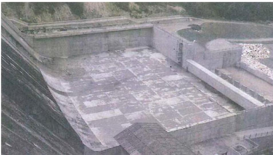
*Figura 12 – Lavori 2<sup>a</sup> lotto, vasca di dissipazione, 2010*
