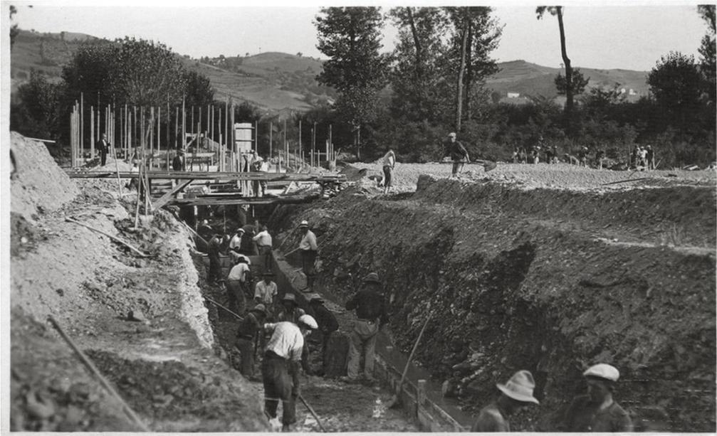
*Figura 7 – Costruzione traversa di Castell'Arquato, 1933*
