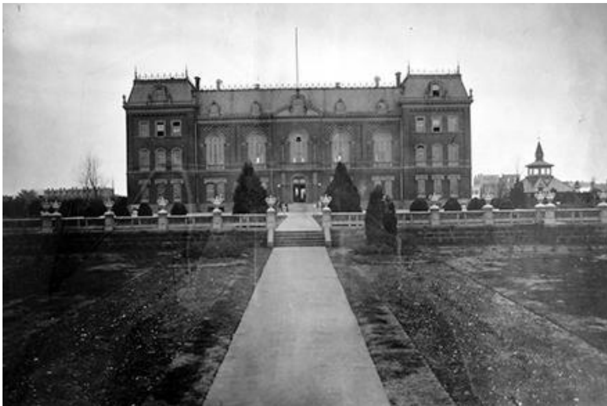
Figura 1- Facciata sud del vecchio edificio amministrativo dell'USDA
