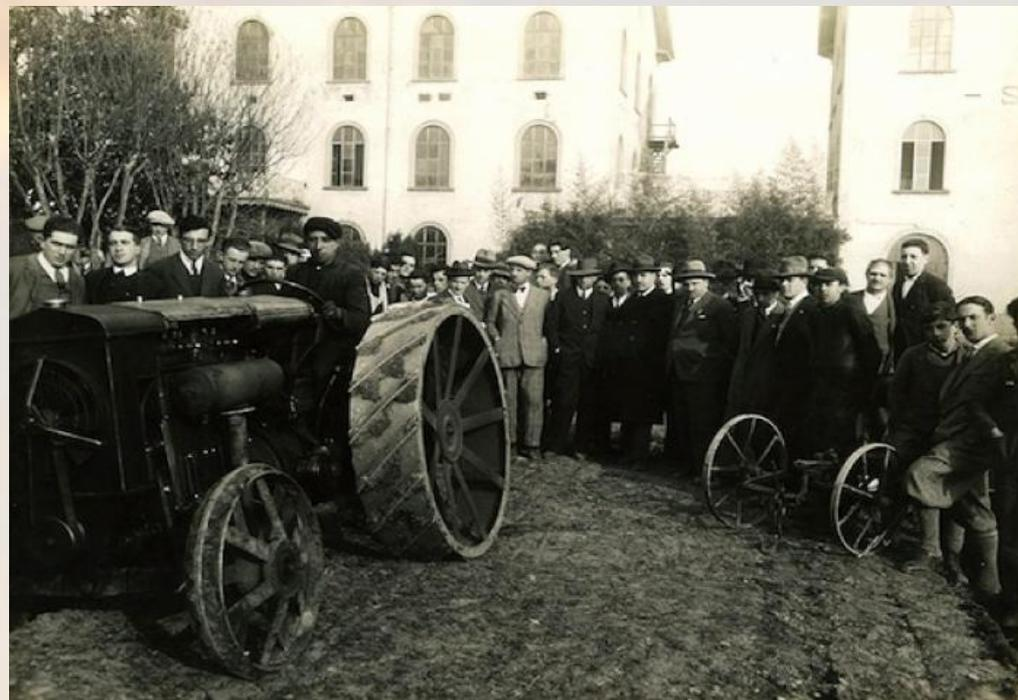
Motore diesel a 2 cilindri orizzontali da 12723 CC, cambio a 3 marce, velocità di 15 km/h, prese di moto laterale su volano - puleggia
