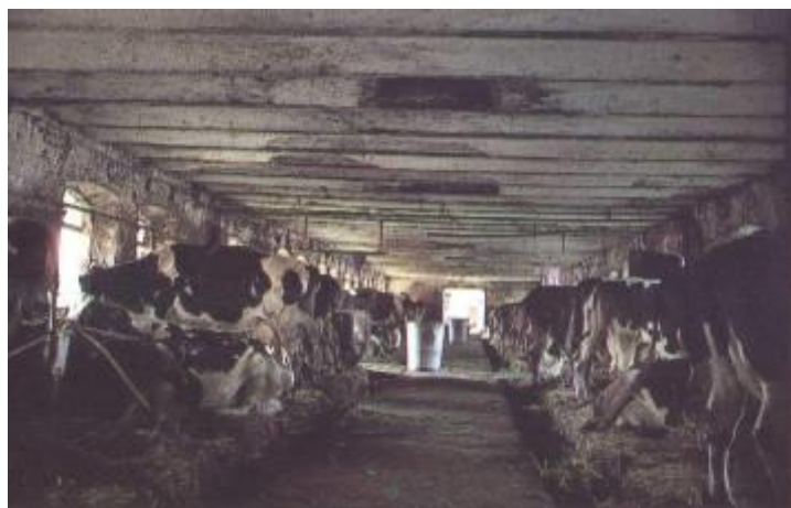
La stalla della cascina Borasca di Casalpusterlengo (foto Bassi)
