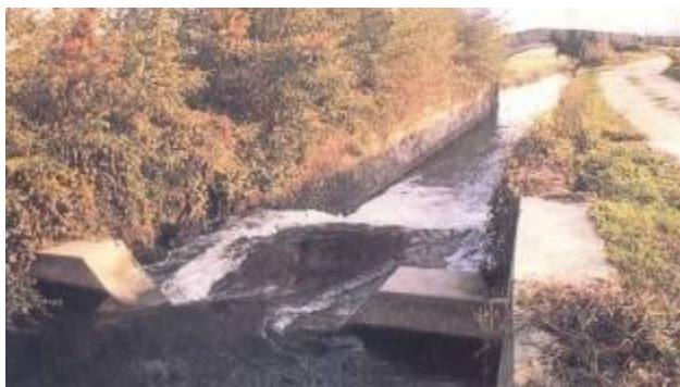
Una chiusa sul Canale Muzza (foto Bassi).
