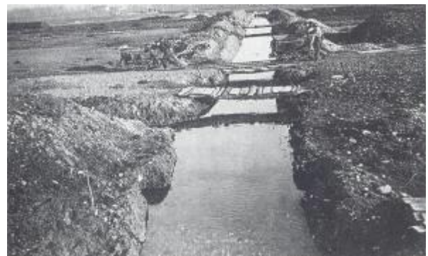
A sinistra: l'avvio dell'opera di bonifica promossa e realizzata con indomita tenacia nella propri fondi dalla famiglia GropPELLI negli anni Quaranta del Novecento, in particolare lo scavo del canale di scolo. A destra: il canale quasi ultimato (foto GropPELLI).
