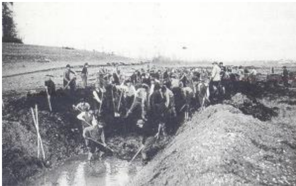
A sinistra: l'avvio dell'opera di bonifica promossa e realizzata con indomita tenacia nella propri fondi dalla famiglia GropPELLI negli anni Quaranta del Novecento, in particolare lo scavo del canale di scolo. A destra: il canale quasi ultimato (foto GropPELLI).
